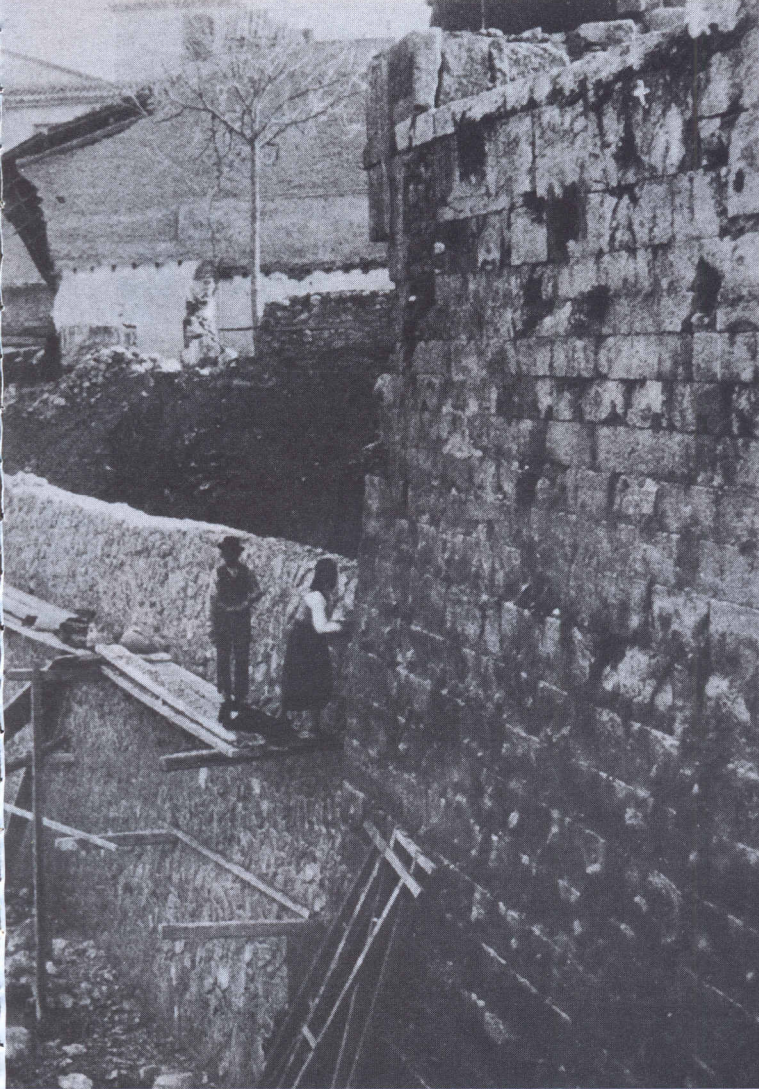
Κατασκευή του τμήματος του ηλεκτρικού σιδηροδρομικού δικτύου Θησείου – Μοναστηράκι (Γεννάδειος Βιβλιοθήκη).
