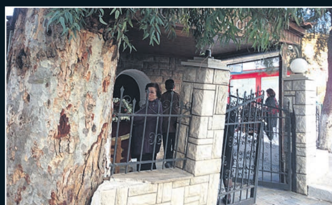
Στο έλεος του βρίσκεται το εκκλησάκι του Αγ. Αθανασίου, επί της οδού Λιοσίων. Μόνοι οι πιστοί προσπαθούν να το κρατήσουν σε καλή κατάσταση. Οι αρμόδιοι απλά κωφεύουν...
